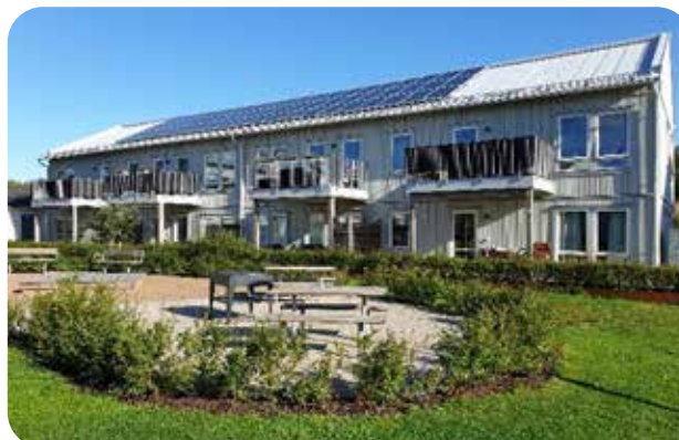
Solceller installerades på Markkärrsvägen i Höviksnäs.
