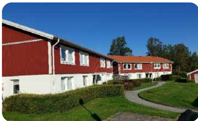
Tapirvägen i Myggenäs består av två byggnader med totalt åtta lägenheter fördelat på fyra 2:or och fyra 3:or.
